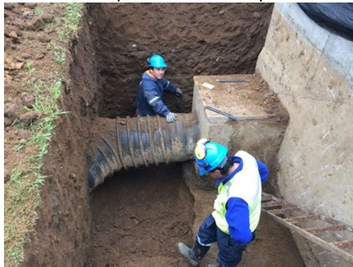
Figura N° 5 Excavación para conexión tubería en paralelo.
