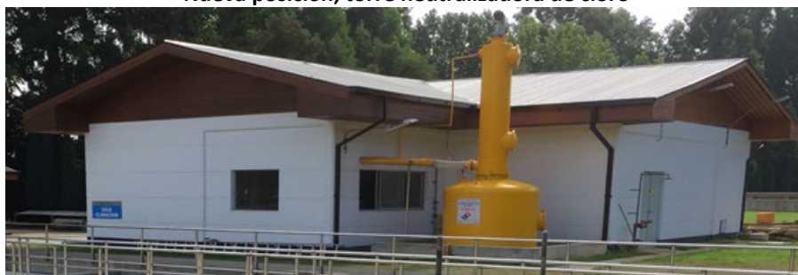
Figura N° 8 Nueva posición, torre neutralizadora de cloro
