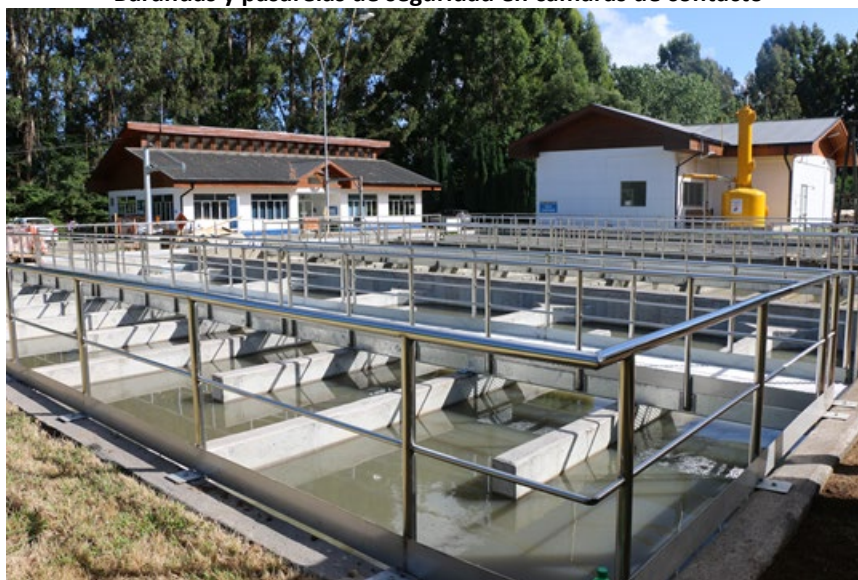
Figura N° 10 Barandas y pasarelas de seguridad en cámaras de contacto
