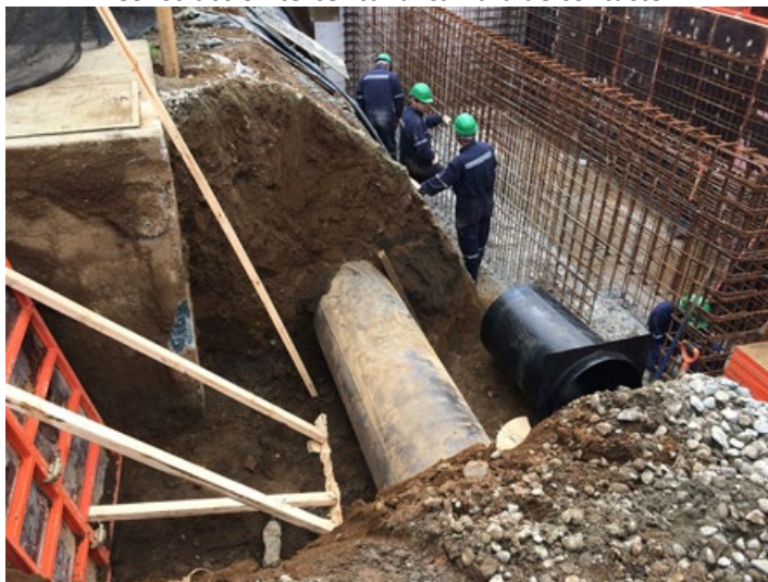
Figura N° 7 Construcción tercer canal cámara de contacto.
