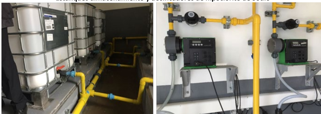
Figura N° 9 Estanques almacenamiento y dosificadores de hipoclorito de Sodio
