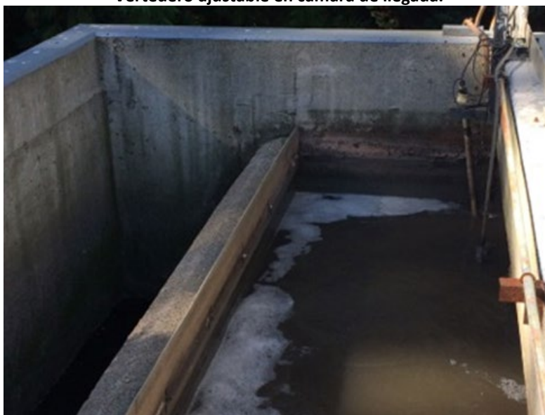
Figura N° 4 Vertedero ajustable en cámara de llegada.
