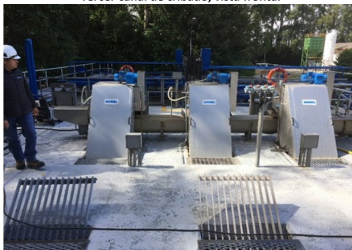
Figura N° 3 Tercer canal de cribado, vista frontal
