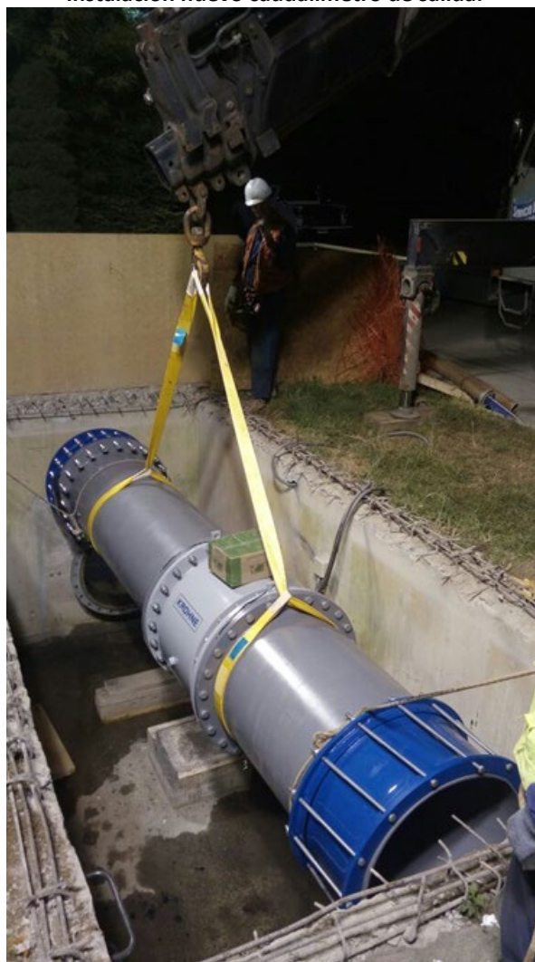
Figura N° 9 Instalación nuevo caudalímetro de salida.
